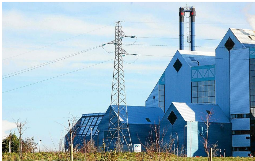
Figure 148 : Unité de Valorisation Energétique de Brieç
