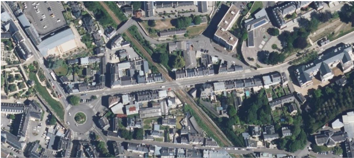
Figure 25 : Traversée urbaine d'une voie ferrée à Quimper
