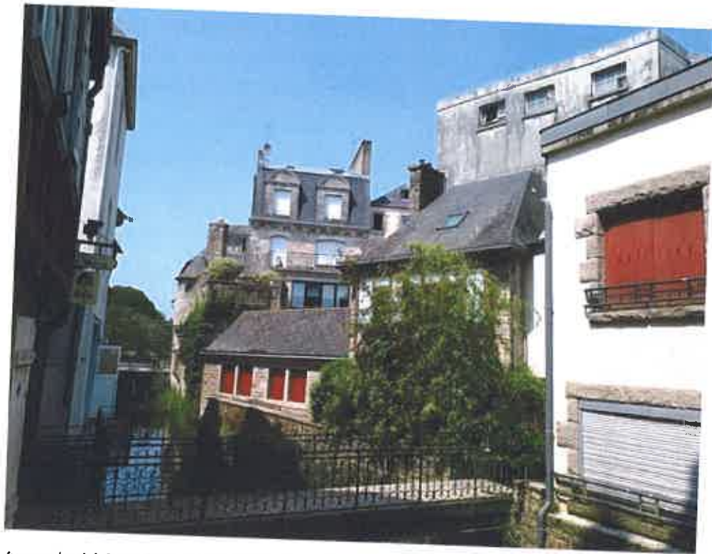
Vue sur les bâtiments de la parcelle BL 570 avec en arrière-plan la façade Ouest de la galerie
