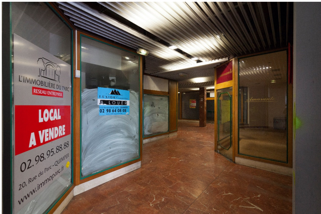
Vue rez-de-chaussée de la galerie commerciale
