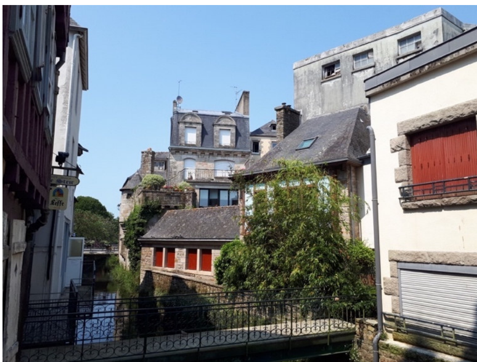
Vue sur les bâtiments de la parcelle BL 570 avec en arrière-plan la façade Ouest de la galerie
